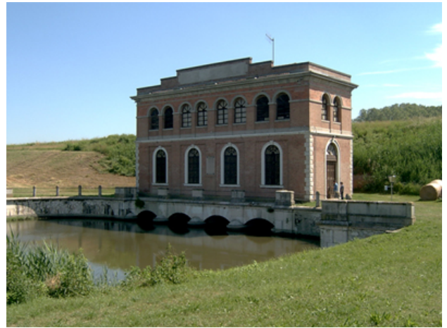
Botte a sifone sotto il Secchia - San Siro di San Benedetto Po
