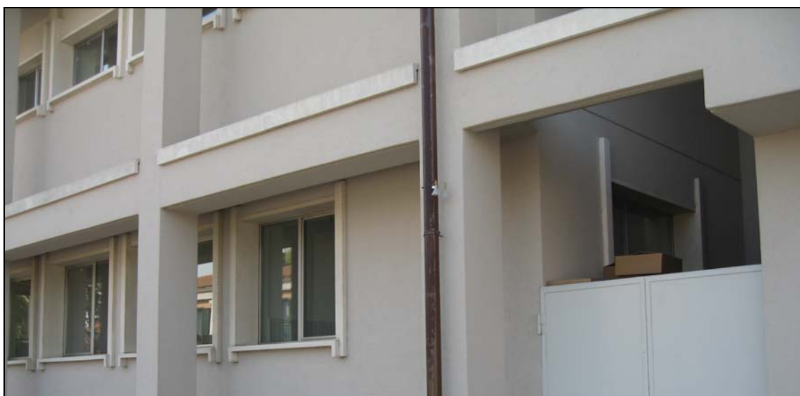
Figura 6: Particolare dei due campionatori appesi ad un canale di scolo dell'edificio scolastico
